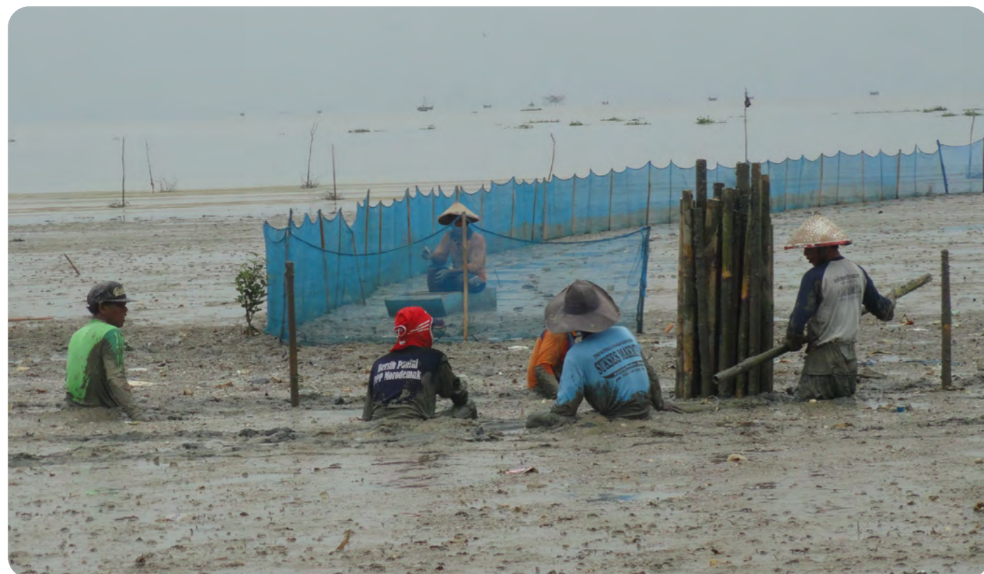
Kelompok masyarakat memasang struktur perangkap sedimen sederhana. © Kuswantoro
