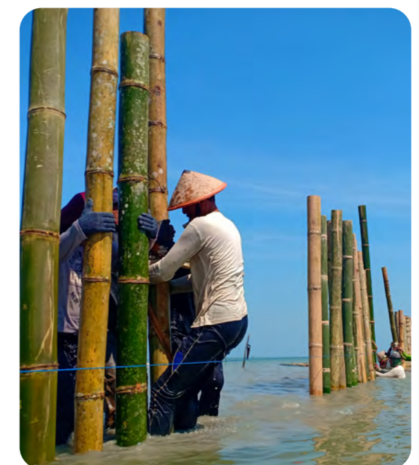
Anggota masyarakat bekerja sama membangun perangkat sedimen permeabel di Desa Timbulsloko Indonesia. © Kuswantoro
