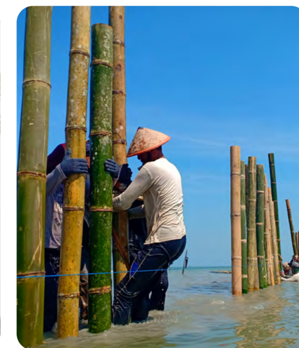
Los miembros de la comunidad trabajan juntos para construir una estructura permeable de captura de sedimentos en la aldea de Timbulsloko, Indonesia. © Kuswantoro
