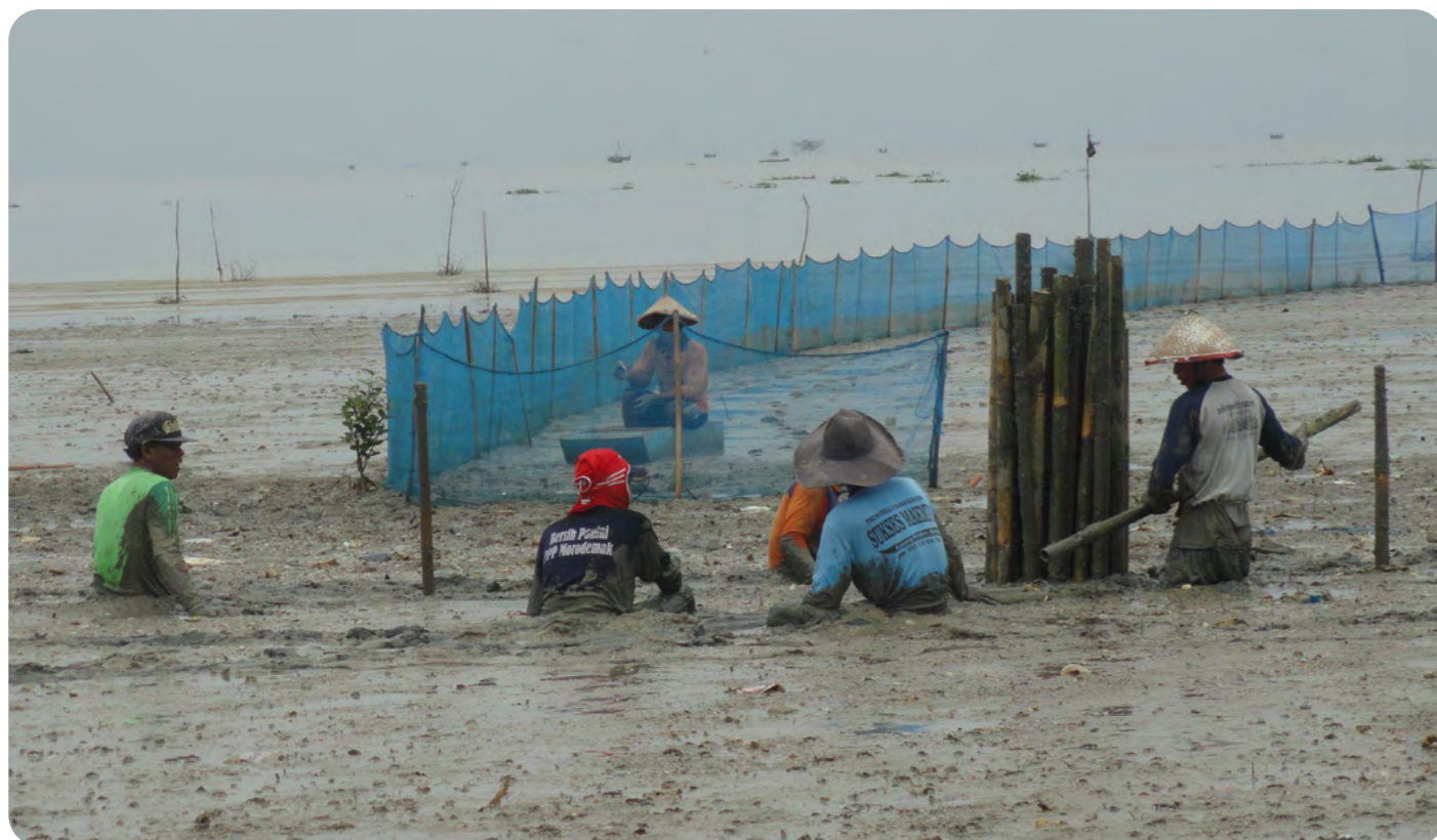
El grupo comunitario instala una estructura simple de captura de sedimentos. © Kuswantoro
