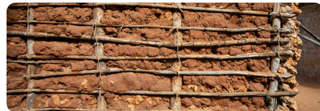
Los usos tradicionales de los manglares, como el uso de postes de manglar para la construcción de viviendas aquí en Mtangawanda, Kenia, solo se pueden aprender en un contexto local. © Sarah Waiswa
