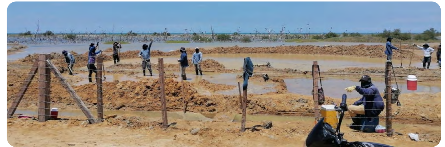
El conocimiento local y ancestral informó el proceso de excavación de canales para asegurar los flujos de agua hacia y desde los manglares en Musichi. © Adriana Daza
